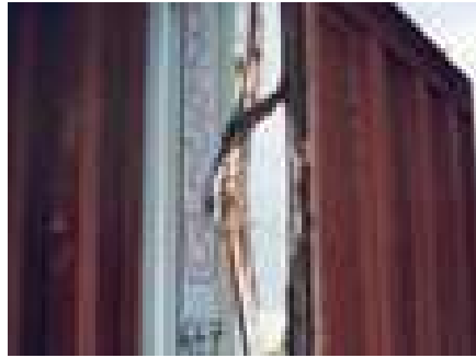
9 Loose door rubber gasket.
